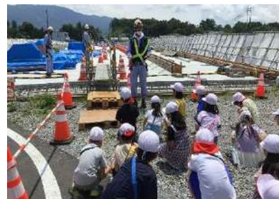
「地域に学ぶ」 今村橋の建設現場を見学する2年生
