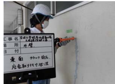
外壁クラック補修
