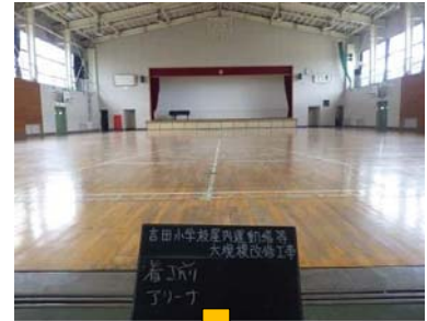
内装改修 (床研磨後塗装)
