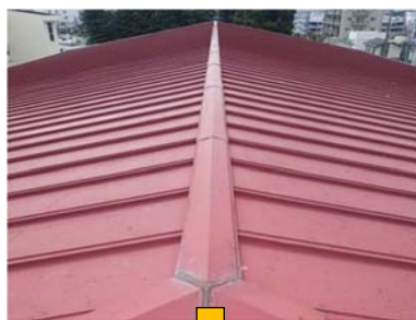
屋根防水改修 (カバー工法)
