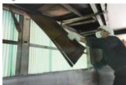
改修作業中の写真
