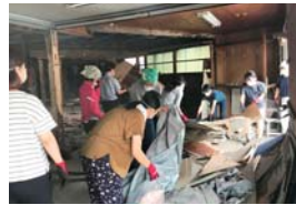
ふるもの市の会場である空き家を改修しています。
