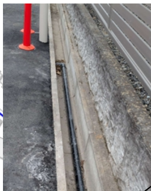
排水路内にパイプを高原通り 線まで設置
