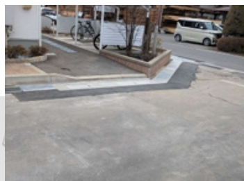
高原通り線の合流地点 の排水路整備
