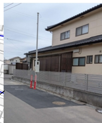
浸水箇所に排水ポンプを設置
