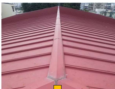
屋根防水改修（カバー工法）
