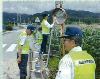
町内の小学校・保育園・幼稚園の近くに設置されたカーブミラーの点検・清掃作業を実施した。(長野)
