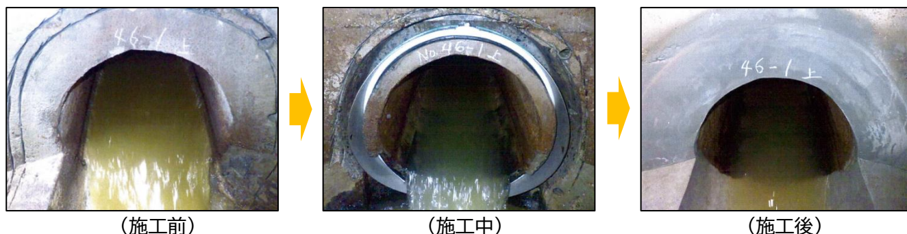
写真 6.5 管路耐震化工事施工例(内径 600mm)
