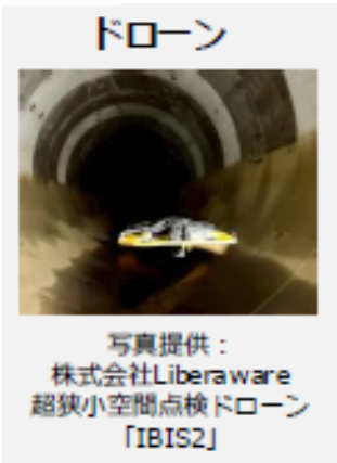
図 6.2 ドローンを活用した管路内調査
