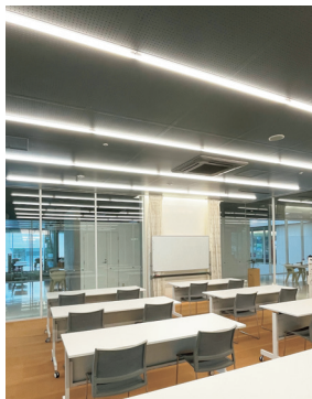
年間1200万円余の電気代が削減される照明のLED化
