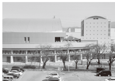
天井改修が必要なレザンホール
