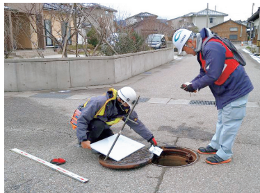
▲下水道課の派遣職員による羽咋市での下水道設備の点検の様子
