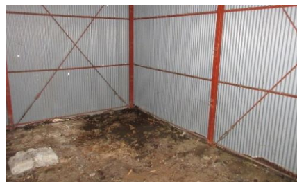
裏庭倉庫 内部
