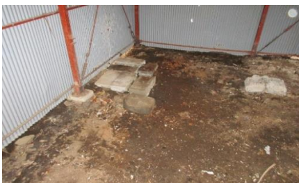
裏庭倉庫 内部
