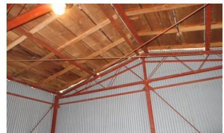
裏庭倉庫 内部
