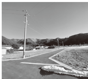
宅地醸成された床尾区
