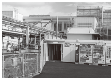
改修が進む村井駅
