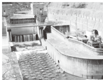
片平取水口 地下導水管で本山浄水場へ
