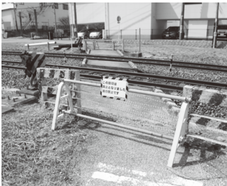
廃止された踏切
