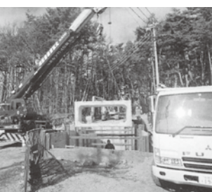
配管工事の様子
