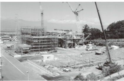
信州Fパワー事業 発電所建設進む
