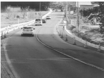
善知鳥峠への堆雪帯工事が進む
