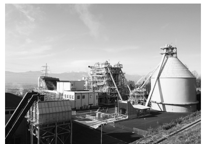
燃料材の不足が心配。木質バイオマス発電所
