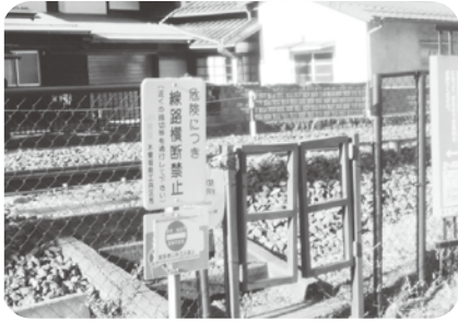
撤去予定の作馬道、踏切新設予定地付近
