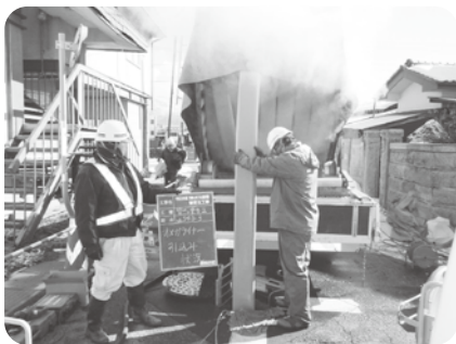
下水道管老朽管補強工事
