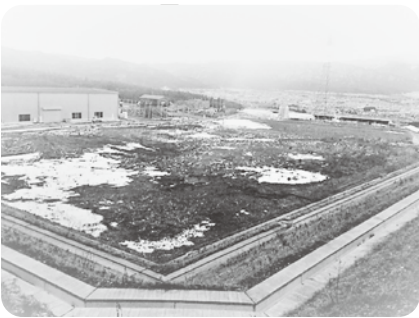
F・パワープロジェクト発電施設建設予定地
