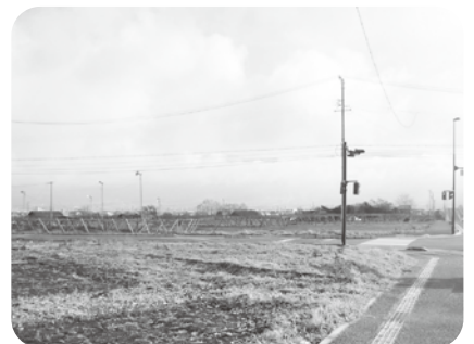
新体育館建設予定地
