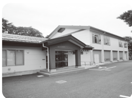
吉田西防災コミュニティセンター
