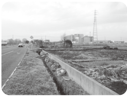
都市計画道路の側溝
