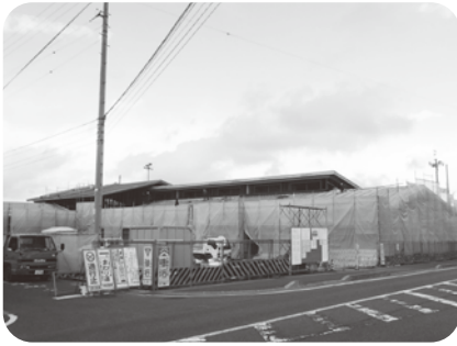
建設中の保育園、児童館
