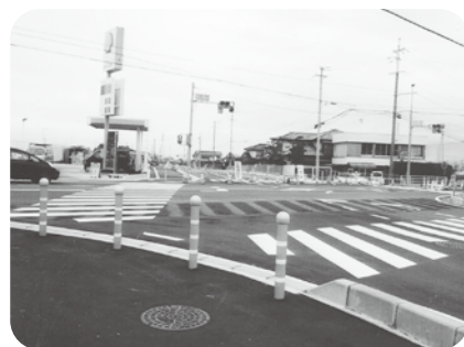
供用開始となった広丘西通線19号と西通線の接点付近
