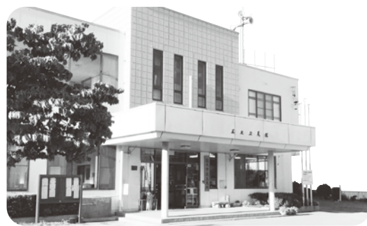
手狭な現広丘支所
