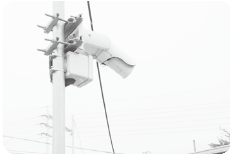
設置された防犯カメラ
