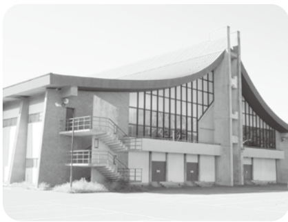
現 市立体育館
