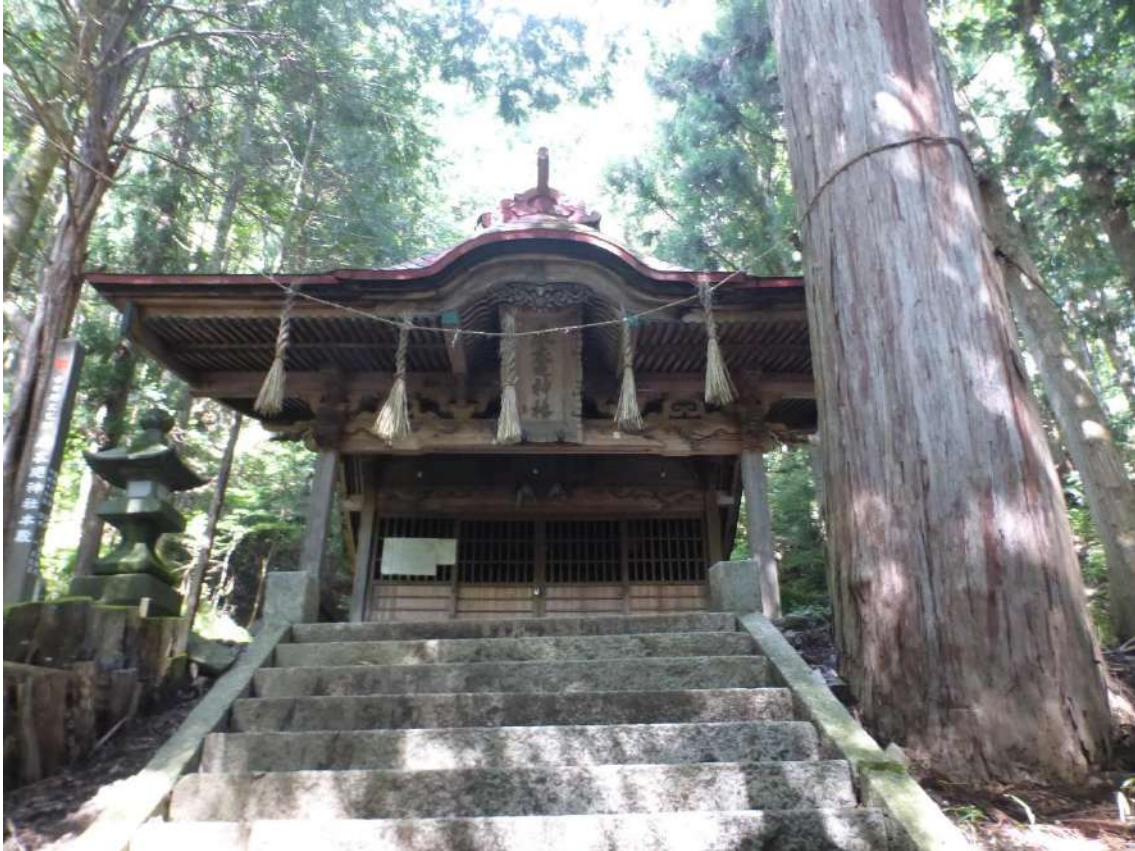
麻衣迺神社本殿(市有形文化財・贄川)
