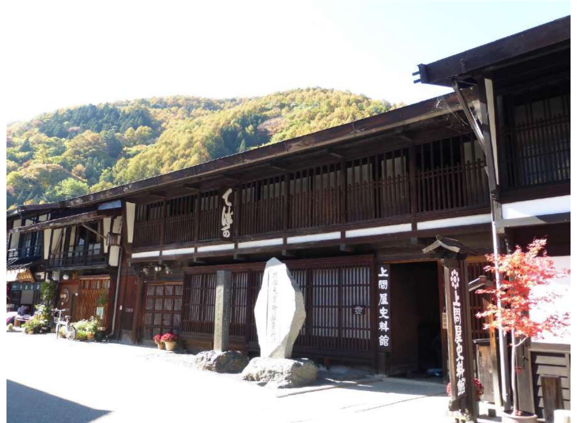
手塚家住宅(重要文化財・奈良井)
