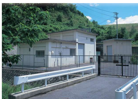
出典：長野県ホームページより 写真 1 奈良井発電所
