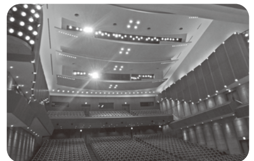
改修が予定されているレザンホールの照明設備
