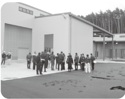
製材機械設置を待つ製材棟
