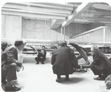
埼玉県「免震構造の防災センター」
