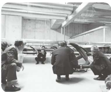
埼玉県「免震構造の防災センター」
