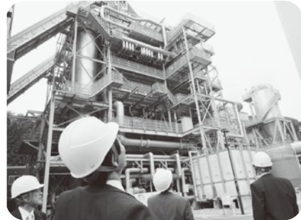
吾妻バイオパワー 「発電所外観を視察」
