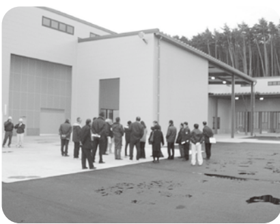
製材機械設置を待つ製材棟
