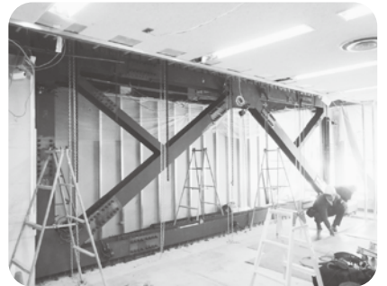
庁舎改修事業 耐震化のための補強ブレース
