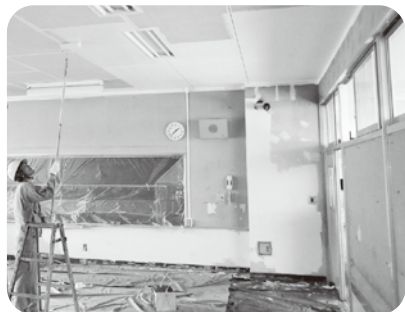
夏休み中に改修工事が行われた塩尻東小
