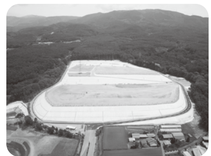
信州Fパワープロジェクト建設予定地 (西松・ハシバ特定建設工事共同企業体撮影)
