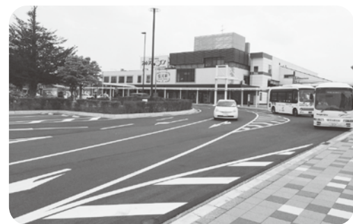
整備事業が完了した塩尻駅前
