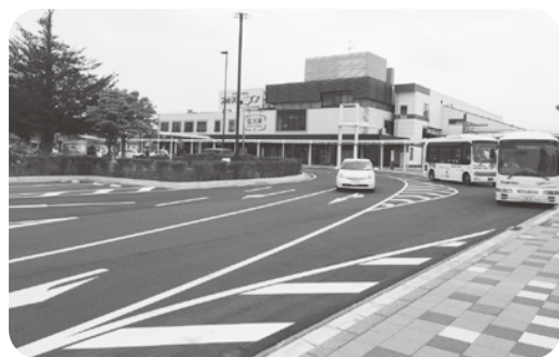
整備事業が完了した塩尻駅前
