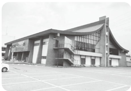
現 市立体育館
