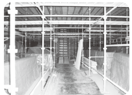
改修工事が進む議場
