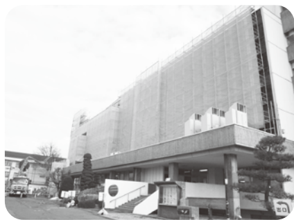
改修中の庁舎
