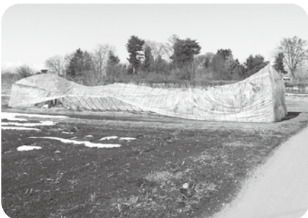
雪の重さで押しつぶされたビニールハウス
