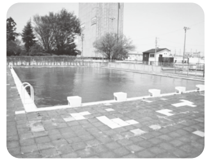
改修予定の吉田小学校プール
