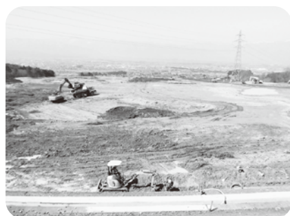
造成中のFパワープロジェクト建設予定地
