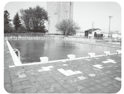
改修予定の吉田小学校プール
