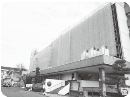
改修中の庁舎
