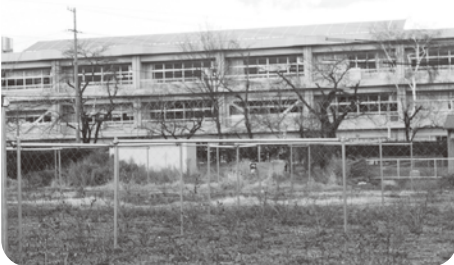
太陽光発電設備が設置された 広丘小学校南校舎屋根
