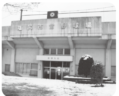
改修が予定されている市営野球場
