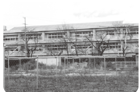
太陽光発電設備が設置された広丘小学校南校舎屋根
