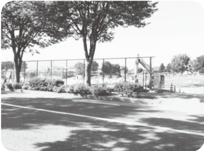
改修工事中の中央スポーツ公園サッカー場
