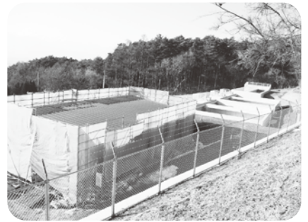
移設更新中の片丘浄水場
