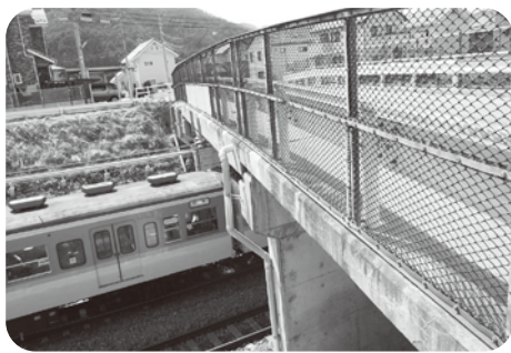
改修が始まる みどり湖駅跨線橋
