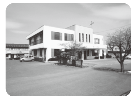
老朽化が進む広丘支所
