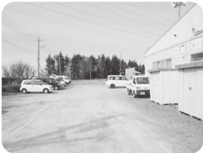
(仮称)ふれあいセンター広丘建設予定地
