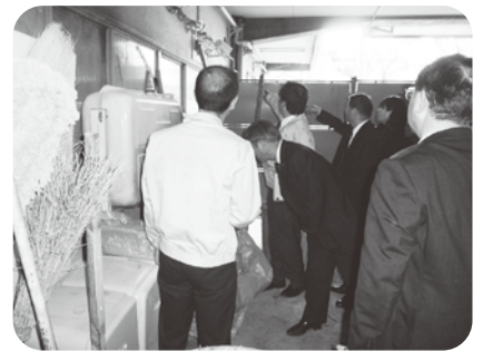
市庁舎の火災現場を視察
