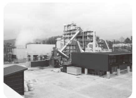
木質バイオマス発電装置
